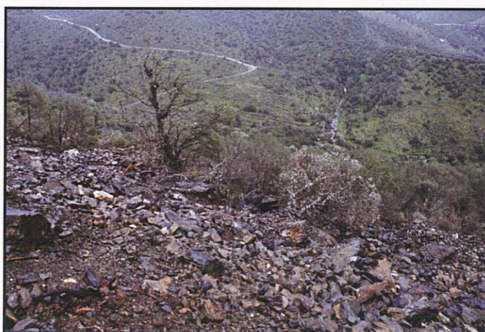
Figura 4.22 – Deslizamento de terras, destruindo azinheiras ao longo do núcleo AC9M1 de azinhal-zimbral (9560pt1).
